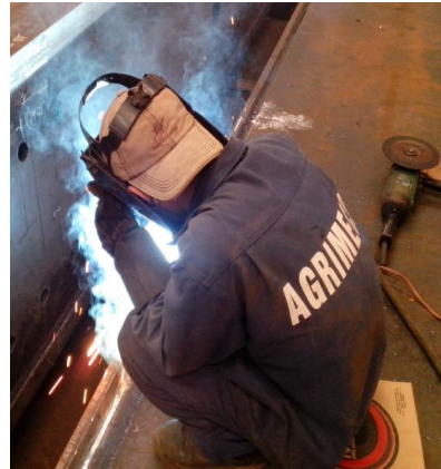
Kiểm soát quá trình hàn
