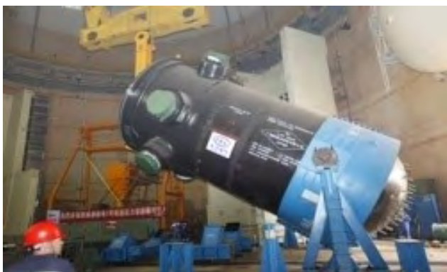
Hình 3. Lắp đặt thùng lò phản ứng tổ máy I nhà máy Phòng Thành (2013).
